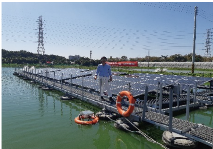
圖 2-3 水試所與向陽優能電力股份有限公司共同研發之浮筏型太陽光電養殖系統
