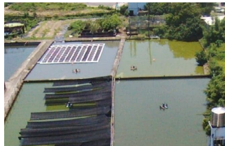
圖 3-2-1a 浮筏型太陽光電設施結合金目鱸養殖試驗（水試所淡水中心竹北試驗場）
